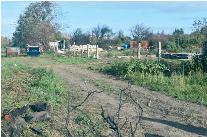
Hier könnte künftig die neue Zuwegung entstehen. Noch laufen die Aufräumarbeiten. Fotos: SLK
